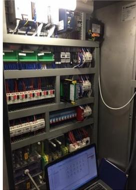
**Proyecto:** *Instalación de Sensor de Temperatura y puesta en marcha de Switching de Bancos de Vaporización en estación de gases*
